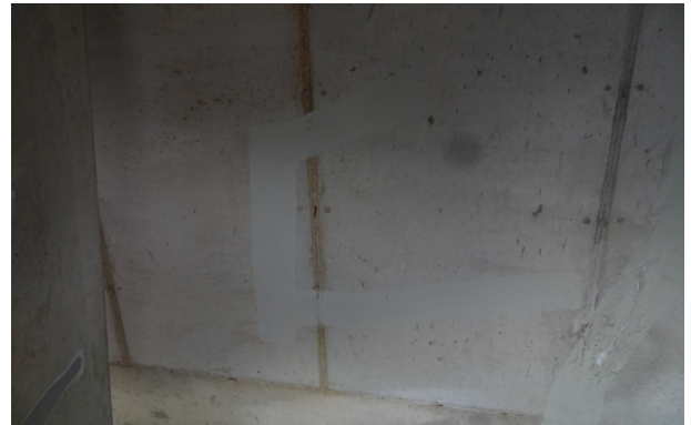
⑪ 균열 0.05mm / 1.2m (보수완료)
