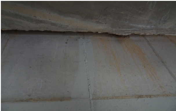
⑱ 균열 0.1mm / 0.8m (보수완료)
