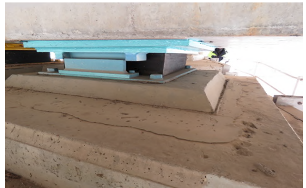
⑧ 무수축물탈 박리 0.1\text{m} \times 0.2\text{m}
