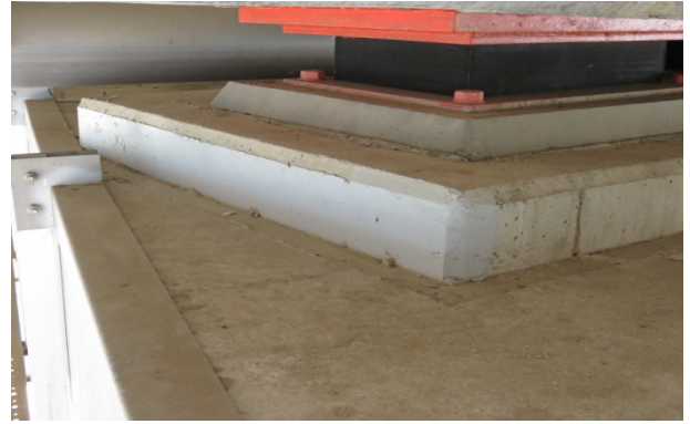
⑧ 받침콘크리트재료분리 0.15m x 1.0m (보수완료)
