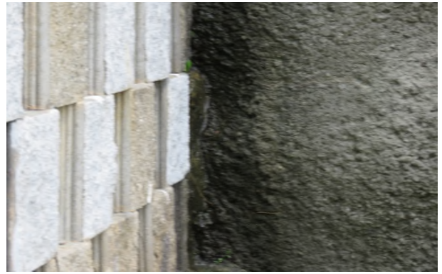
⑫ 누수 0.1\text{m} \times 1.0\text{m}
