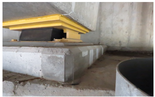
⑬ 받침콘크리트 파손 0.1m x 0.1m (보수완료)
