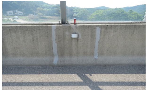
⑯ 균열 0.3mm / 1.5m (보수완료)
