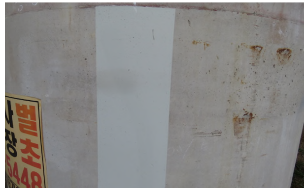
⑫ 균열( 0.3\text{mm} 미만) cw=0.1\text{mm} / 1.4\text{m} (보수완료)
