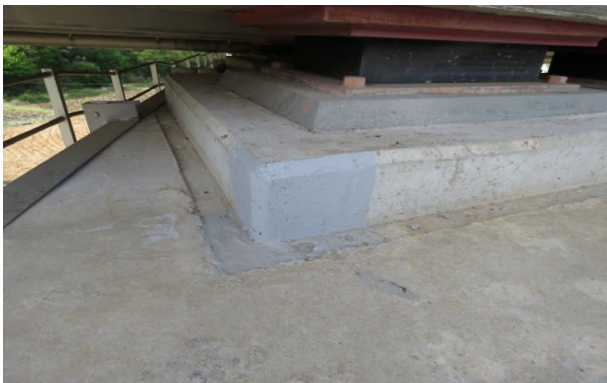
⑫ 받침콘크리트 잡철근미제거 (2EA) (보수완료)
