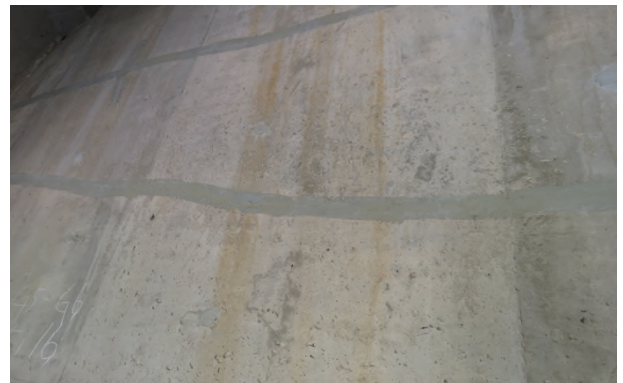
⑯ 균열 0.5mm / 2.0m (보수완료)
