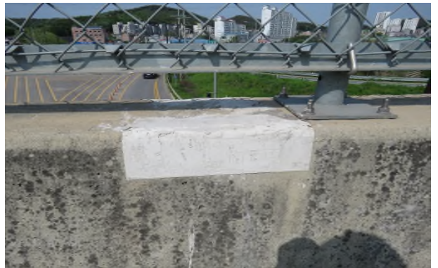
⑧ 파손 0.2m x 0.3m (보수완료)
